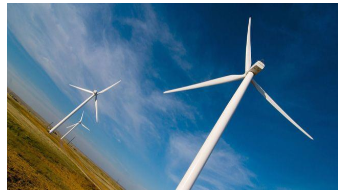
Parques eólicos Duke Energy
