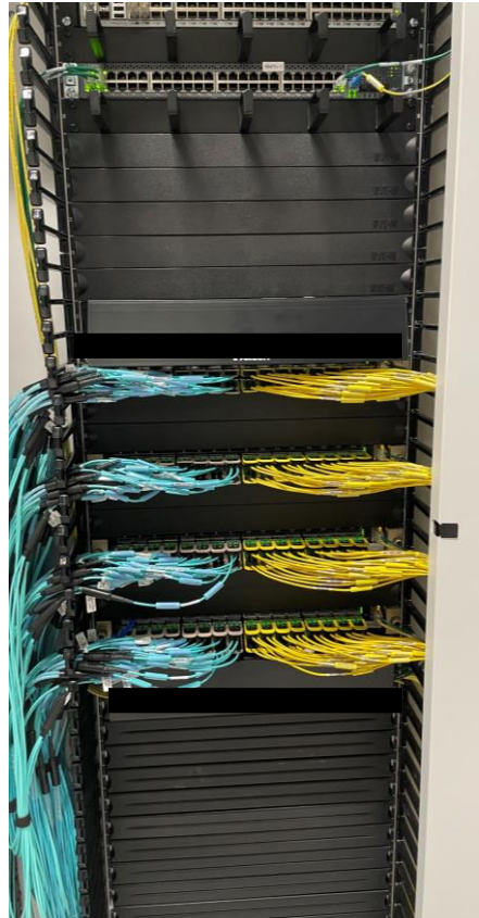
NVIDIA 9700 Switch con 2x NDR 400G Transceivers a 850nm
